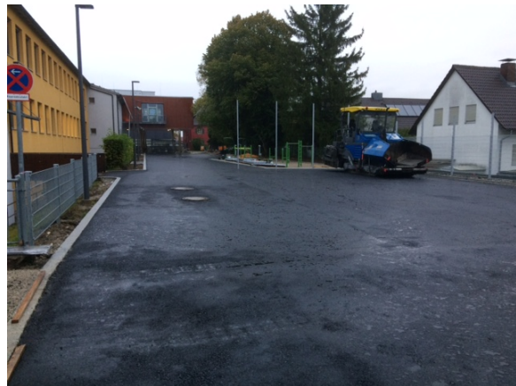
Der Blick auf den neuen Pausenhof vor der Verlegung des Sportbelages
